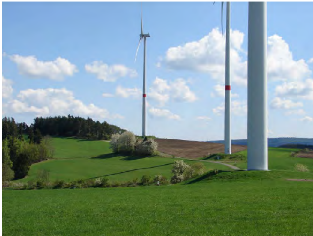
Windenergieanlagen bei Creußen, Lkr. Bayreuth
