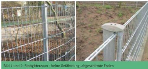
Bild 1 und 2: Stabgitterzaun – keine Gefährdung, abgeschirmte Enden
