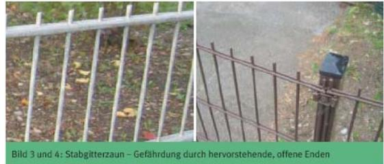
Bild 3 und 4: Stabgitterzaun – Gefährdung durch hervorstehende, offene Enden
