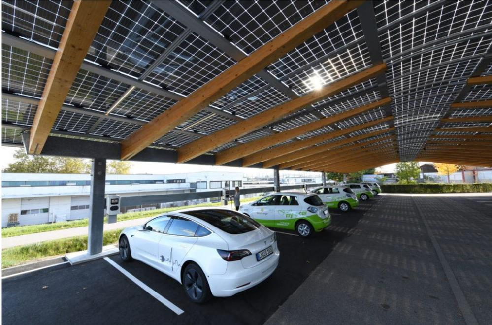
Abbildung 26: Parkplatzüberdachung mit Glas-Glas PV-Modulen (Bildquelle: [www.pv-magazine.de](http://www.pv-magazine.de))
