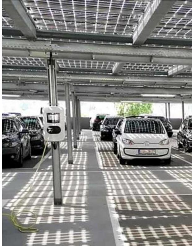
Abbildung 27: An einen Stützfeiler montierte Ladesäule (Bildquelle: [www.hoermann-info.de](http://www.hoermann-info.de))
